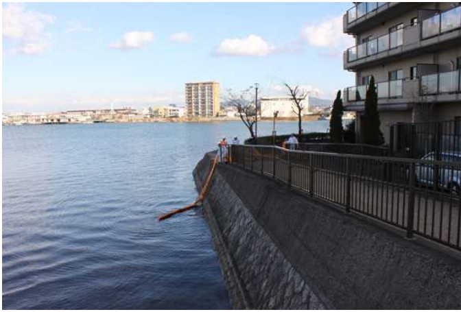
盛越川と瀬田側合流でのオイルフェンス設置
